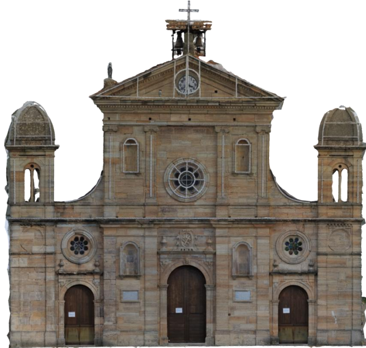
Figura 10: Prospetto facciata (ortofoto).
