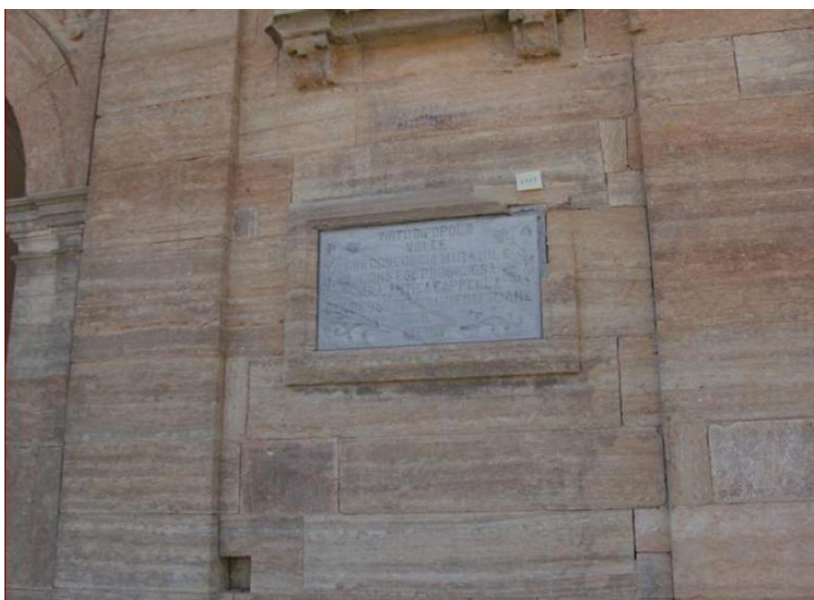
Figura 21: Particolare della facciata in cui è stato localizzato il campione FAC2 da prelevare.
