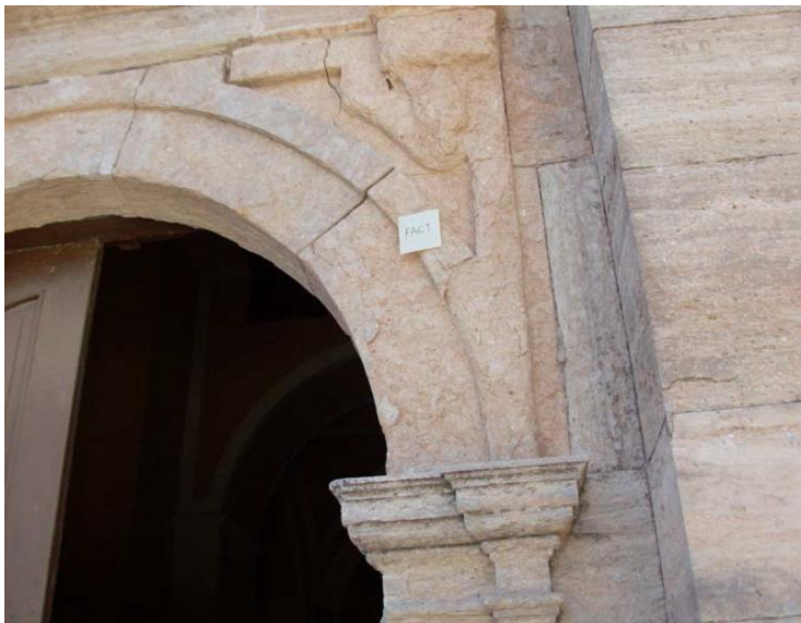
Figura 19: Particolare della facciata in cui è stato localizzato il campione FAC1 da prelevare.
