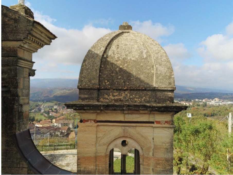
Figura 53: Stato attuale del sistema di allontanamento delle acque meteoriche.
