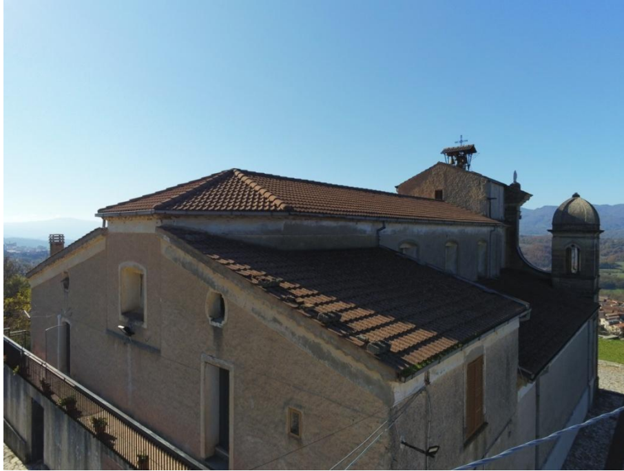
Figura 51: Stato attuale del sistema di allontanamento delle acque meteoriche.
