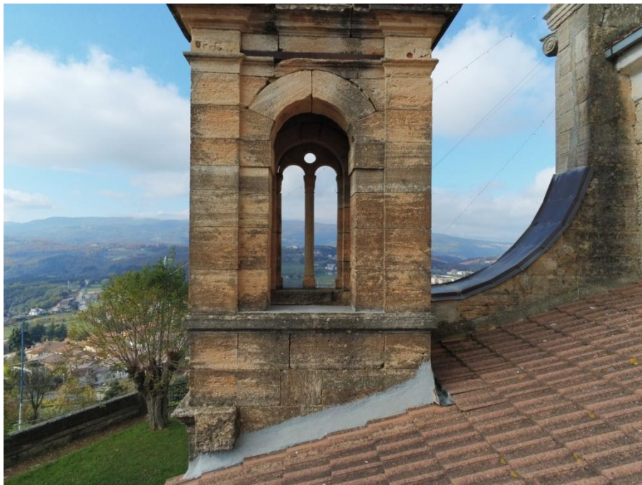
Figura 54: Stato attuale del sistema di allontanamento delle acque meteoriche.
