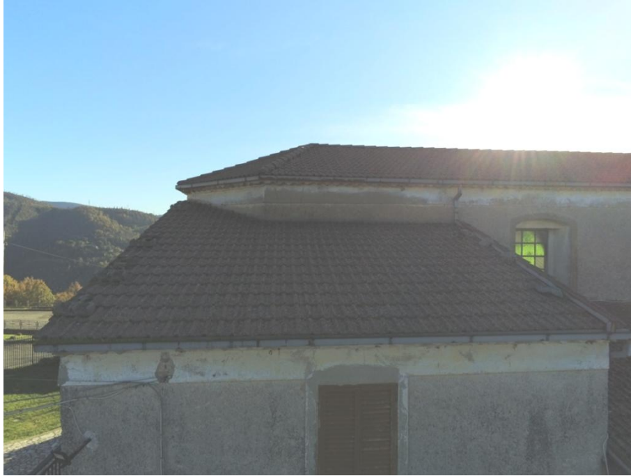
Figura 43: Stato attuale del sistema di allontanamento delle acque meteoriche.
