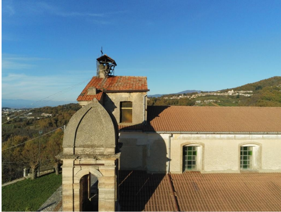
Figura 47: Stato attuale del sistema di allontanamento delle acque meteoriche.
