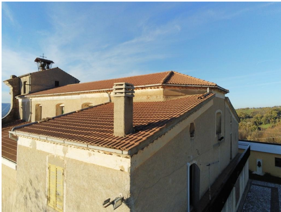
Figura 50: Stato attuale del sistema di allontanamento delle acque meteoriche.
