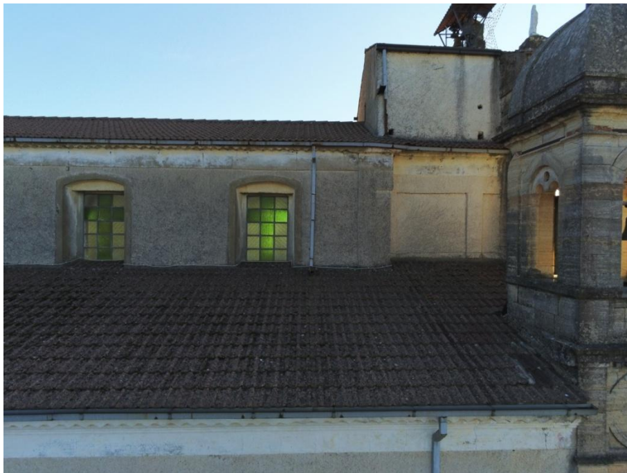
Figura 48: Stato attuale del sistema di allontanamento delle acque meteoriche.
