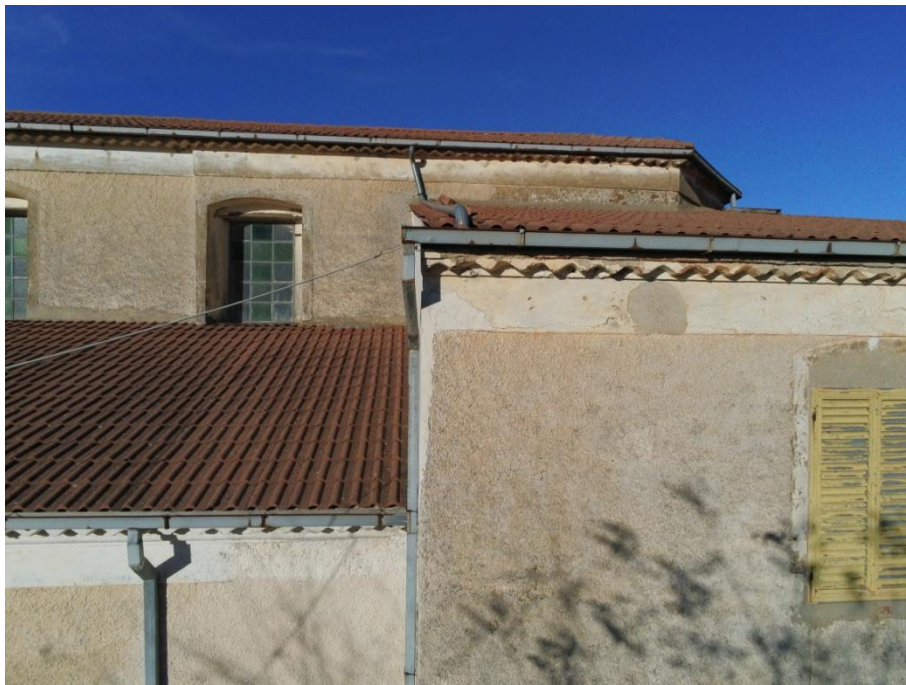
Figura 52: Stato attuale del sistema di allontanamento delle acque meteoriche.
