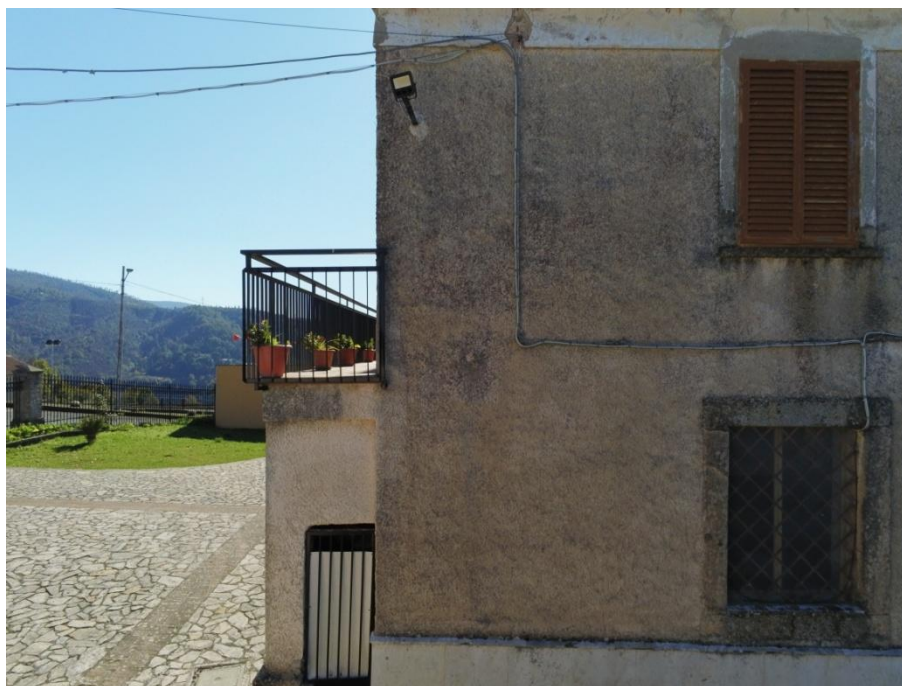
Figura 55: Finestre lato nord da sostituire.
