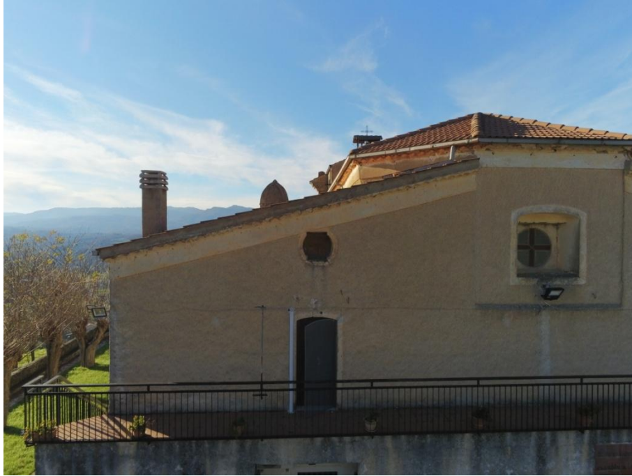
Figura 49: Stato attuale del sistema di allontanamento delle acque meteoriche.
