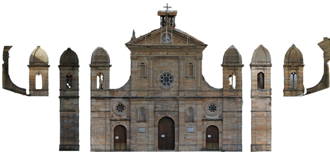
Figura 20: Superfici degradate della facciata del Santuario di Santa Liberata.
