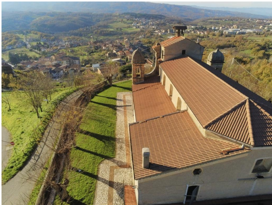
Figura 46: Stato attuale del sistema di allontanamento delle acque meteoriche.
