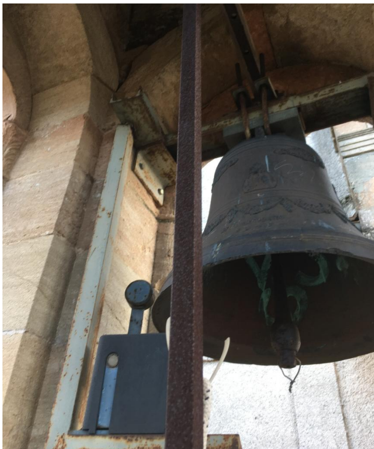
Figura 26: Struttura in acciaio delle campane vincolata alle pareti del campanile.
