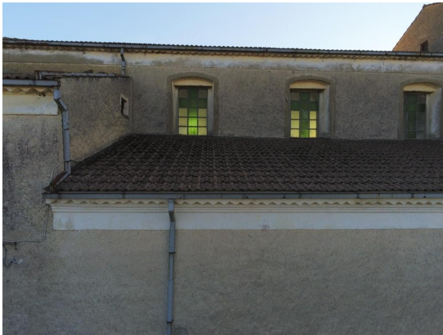
Figura 44: Stato attuale del sistema di allontanamento delle acque meteoriche.
