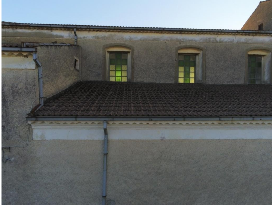
Figura 45: Stato attuale del sistema di allontanamento delle acque meteoriche.
